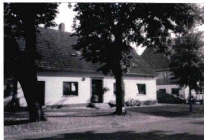
Abb. 15: Die umgebaute „Knabenschule“ (Bild aus heutiger Zeit)
