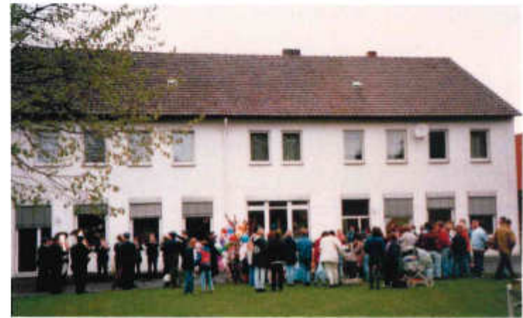
Abb. 16: Die umgebaute ehem. Mädchenschule in der Nordstraße, die heute das Gebäude des Weiberger Kindergartens ist. Das Foto entstand anlässlich eines Kinderschützenfestes (1996).
