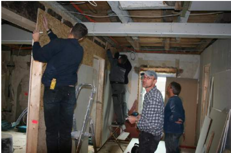
Foto: Arbeiten im Innenraum
