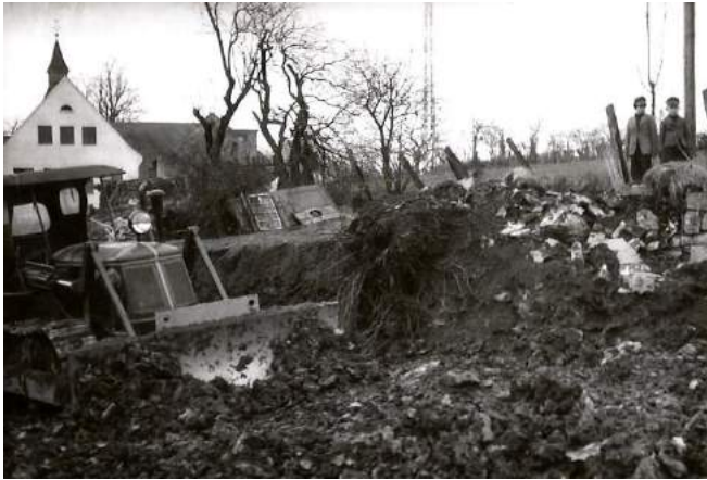
Abb. 13: Der Abriss der alten Schule
