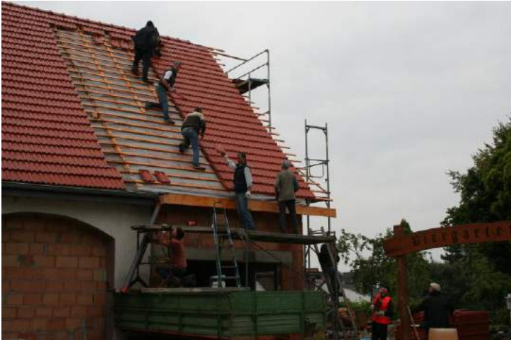
Foto: Arbeiten am Dach
