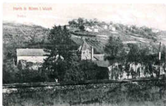
Abbildung 1.25: Im Bildvordergrund sind die Gleise der Almetalbahn erkennbar, hinter dem Bahndamm die Drahtstiftfabrik Kleine. Der Ringelsteiner Fabrikant Lincke – Vorbesitzer des Unternehmens – hatte sich bereits in den 1880er Jahren für den Bau der Bahnstrecke eingesetzt. Die im Verlag Otto Hammerschmidt gedruckte Karte wurde im Mai 1908 abgestempelt. Die Karte wurde mit einem eingblendeten Bild der Burgruine zu Anfang der 1920er Jahre nochmals neu aufgelegt. (Kreisarchiv Paderborn)
