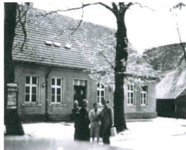
Die Bank war während dieser Zeit in Lehrerwohnung der Weiberger Schule untergebracht. (heute das Anwesen von Familie Wördehoff – Luchten)
