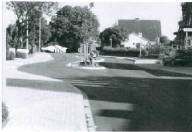
Abbildung 2.6: Der im Rahmen der Schulwegsicherungsmaßnahme geschaffene Bereich der Bushaltestelle an der Volbrexener Str. mit zwei Verkehrsinseln.
