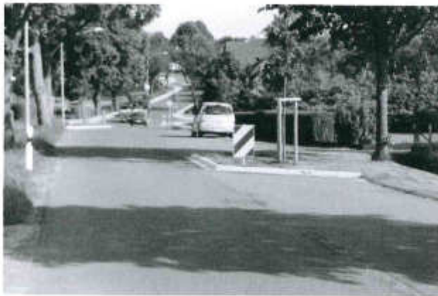
Abbildung 2.7: Der Ortseingangsbereich aus Richtung Büren
