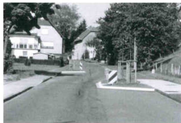
Abbildung 2.16: Der neu gestaltete Straßeneingangsbereich Hohlensiepen (aus Ri. Ringelstein)
