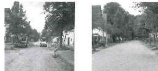
Abbildung 1.4: links: Erneuerungsmaßnahmen an der Dorfstraße; rechts: die frisch gepflasterte Dorfstraße
