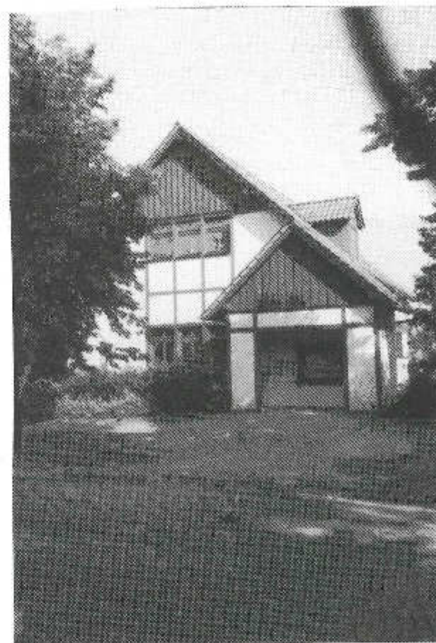
Bild 28: Das am 17. November 1987 eingeweihte neue Feuerwehrhaus. In dem unter einem erheblichen Anteil Eigenleistung fertiggestellten Haus wurde ein Arbeitsraum für städtische Arbeiter sowie eine Unterstellmöglichkeit für Schulkinder integriert.
