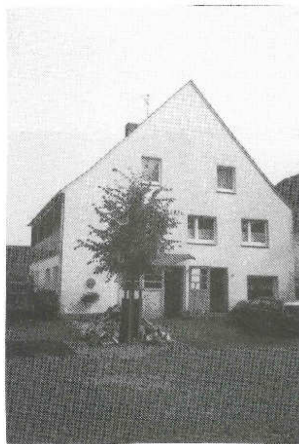
Bild 20: Heute steht hier das neu erbaute Haus Glahe.
