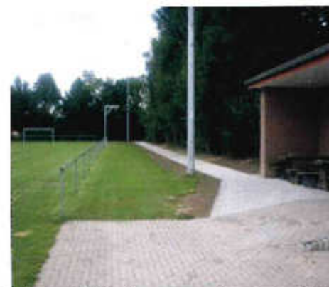
Bild: Ausschnitt der neu gepflasterten Fläche
